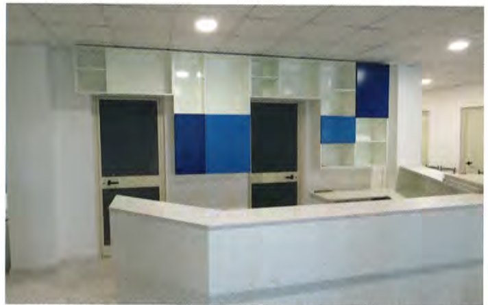
Erster Großauftrag des Norwegischen Krankenhauses in Addis Abeba: fertig installierte Rezeption (2017)
